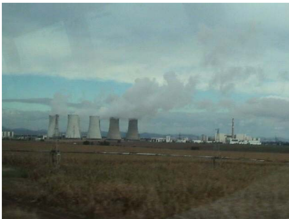
Widok na elektrownię jądrową w Bohunicach
