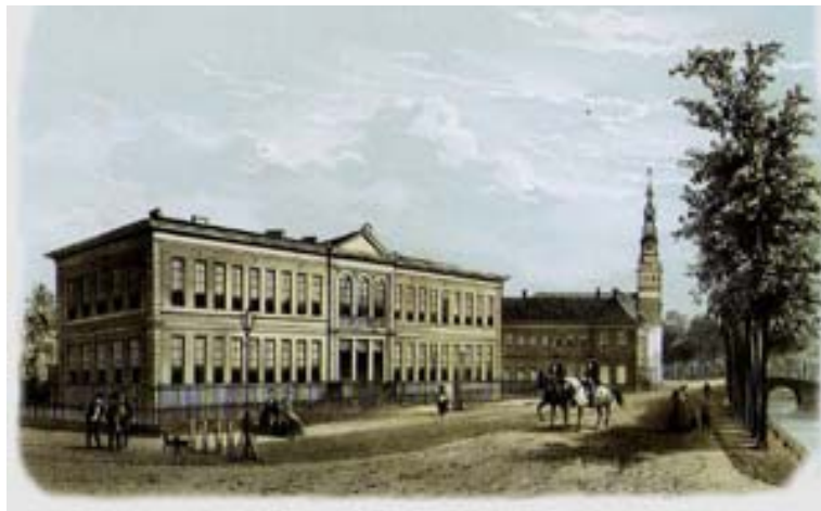
Budynek laboratorium kriogenicznego
