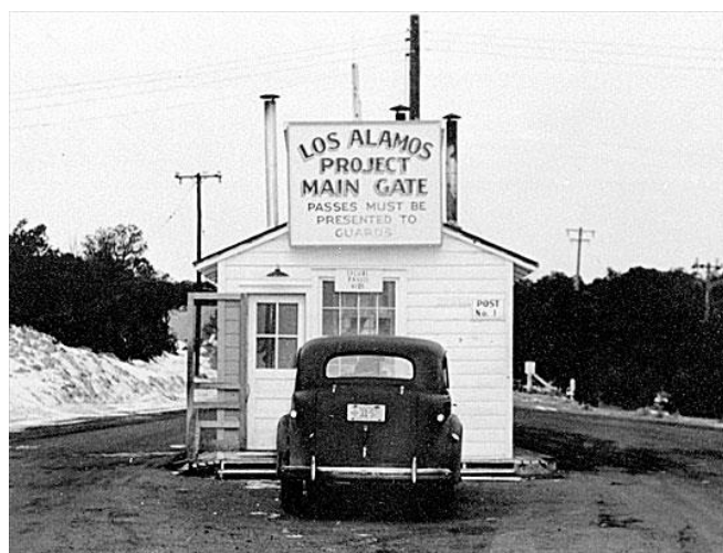
Wjazd na teren Los Alamos w początkowym okresie budowy ośrodka
